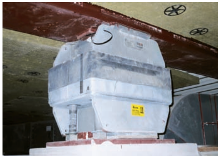
Blick in die Trennfuge mit Stahlfeder-Paket. Fotos: Taubert und Ruhe GmbH
