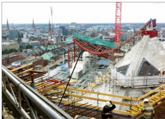
Lüftungsanlagen im Dachhohlraum, das Dach ist noch nicht geschlossen
